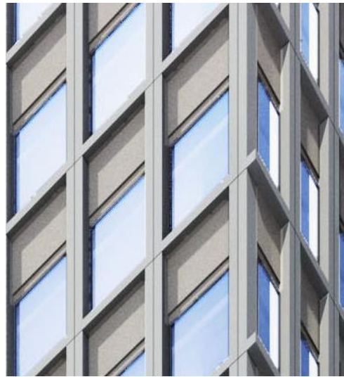
① 繊細なPCフレームによる外装計画
