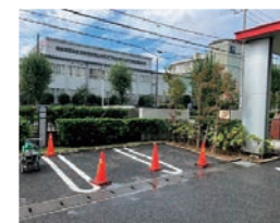
- 駐車場 改修前 -
