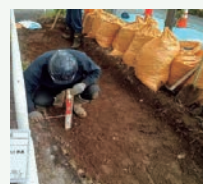
既存土壌すき取り
