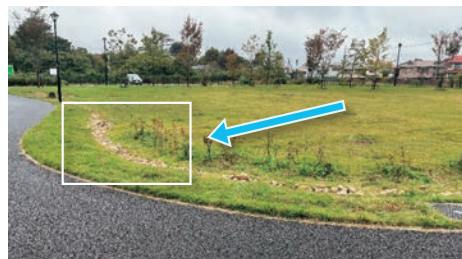
雨は路面に流れ出る前にレインガーデンに浸透
