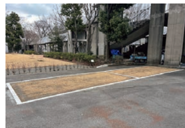
- 舗装道路部 改修後 -
