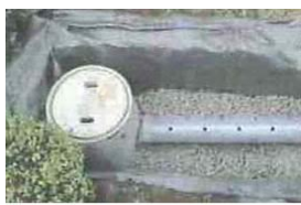
浸透トレンチ
