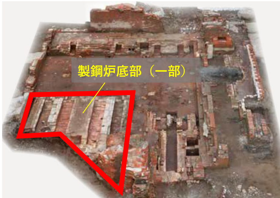
明治期のシーメンス式坩堝炉の底部
