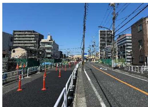
Ⅱ期区間 仮歩道整備完了の状況（令和7年度）
