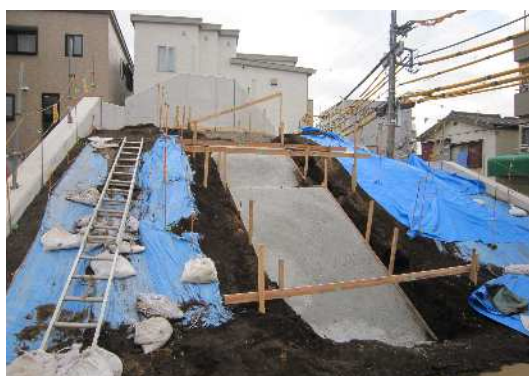
十条富士塚再建工事の状況（令和3年頃）
