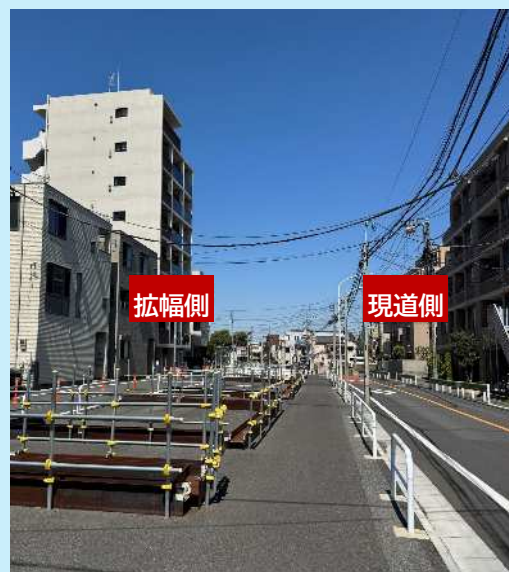
補助第83号線Ⅰ期区間一般部 （南側から北側を望む）
