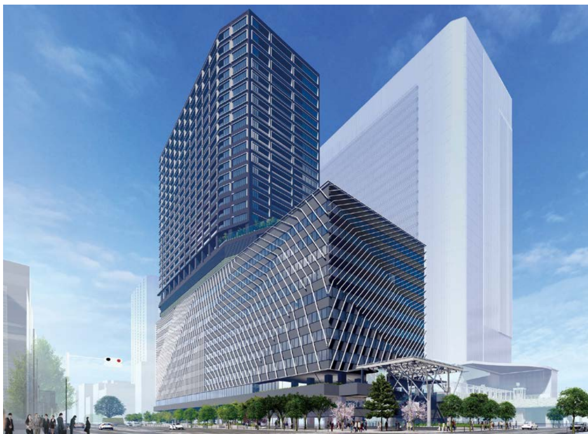
▲建物外観（南西側）
