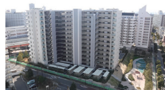
最後の整備街区 PE30 (R4.1.27 建築工完了)
