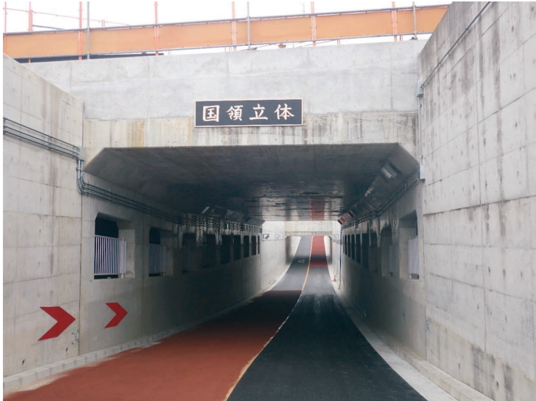
【京王線交差部北側付近】
