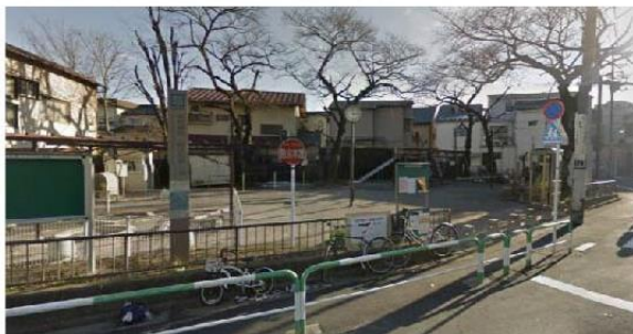
写真⑤ 避難場所を結ぶ避難道路（幅員 8m 拡幅）
