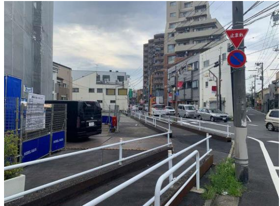
②建替えにより拡幅が進む鐘ヶ淵通り
