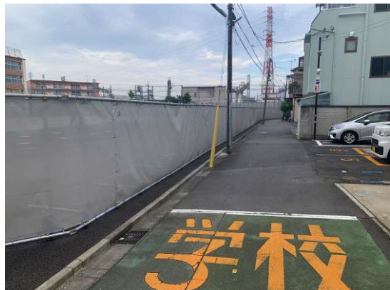
⑳優先整備路線9号から東を見る（東武伊勢崎線西側）
