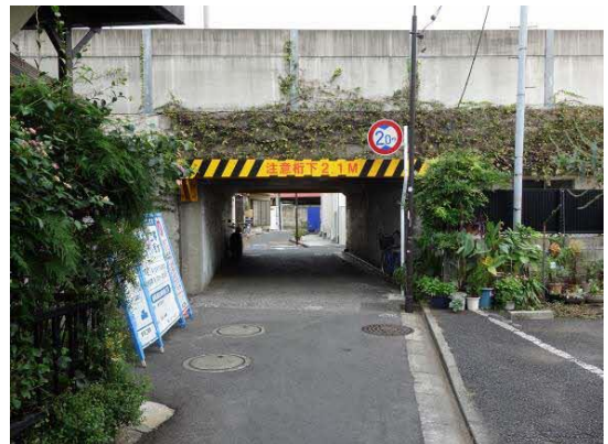
⑧東武伊勢崎線の東西を結ぶ道路は限定されている
