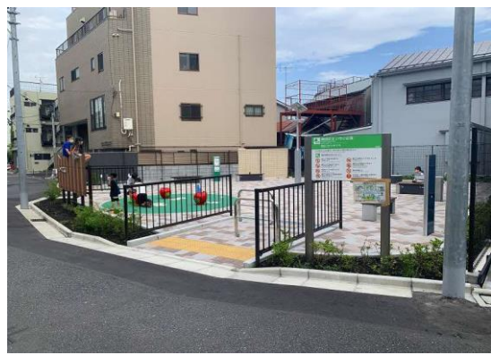
⑭整備された区民広場（優先整備路線1号沿道）
