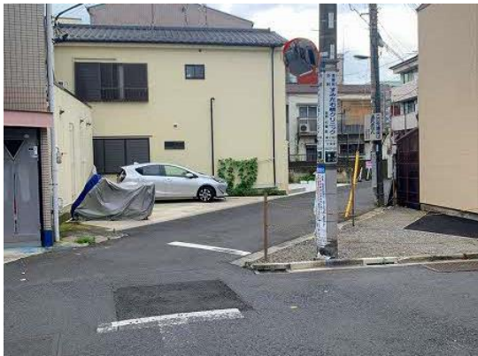
⑤優先整備路線10号の拡幅された交差点部
