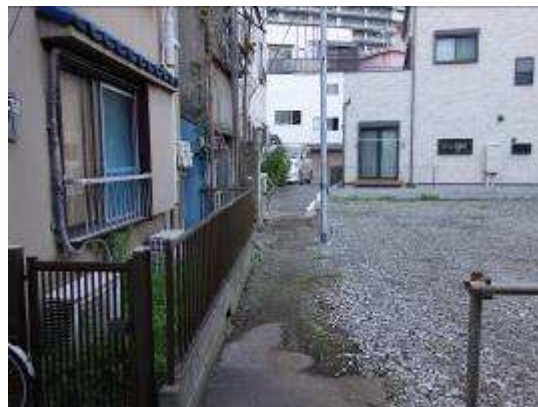
接道不良住宅の除却
