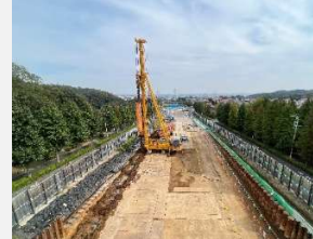
ICT建機による地盤改良工
