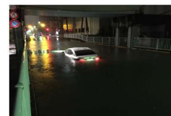
八高線アンダーパス（八王子市）
