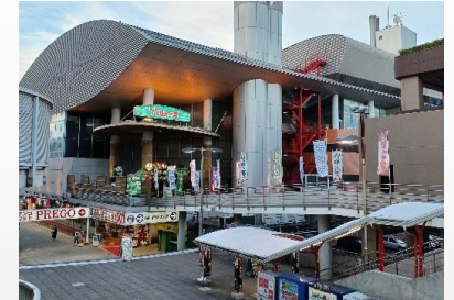
駅周辺の歩行者デッキ：様々なレベルの複層構造で階段・スロープ等が多数存在※4
