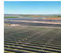
マンサレス太陽光発電所 （スペインシウダード・レアル県）
