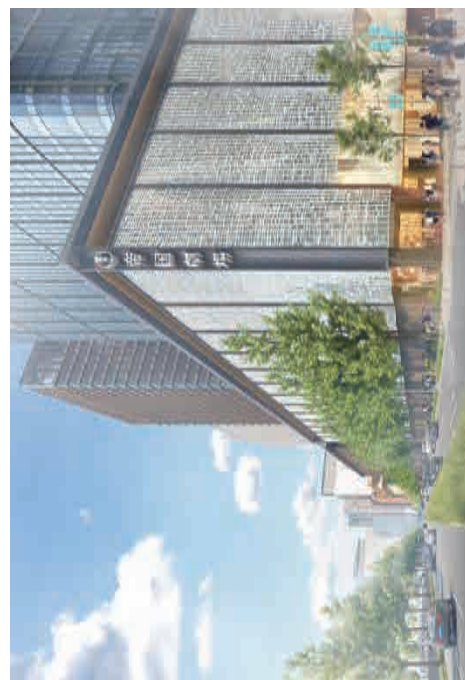
A街区 計画建物のイメージ (日比谷通り南側より計画建物を望む)
