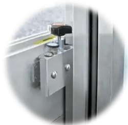
< ドア枠固定部分 >
