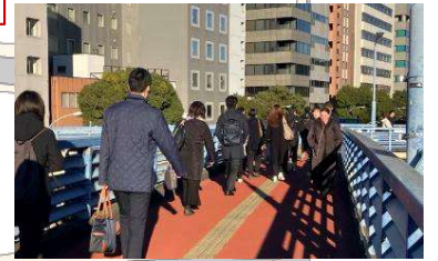
飯田橋歩道橋（階段部・歩行部）
