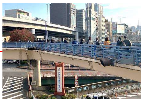
飯田橋歩道橋
