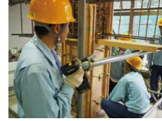
コンクリート型枠製作実習
