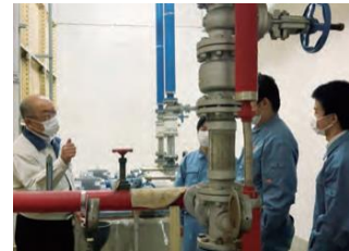
配管等設備整備実習
