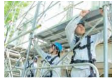
足場組立実習
