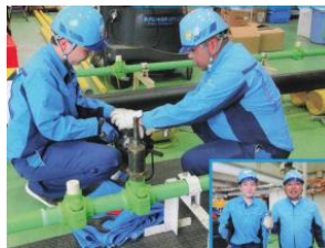
都市ガスパイプライン整備実習
