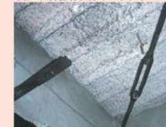
例) 石綿含有吹付けロックウール
