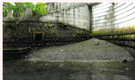
写真 石炭灰造粒物の施工イメージ
