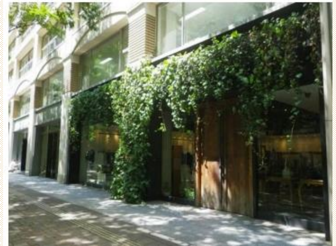
写真 民地の植栽整備（壁面緑化例）
