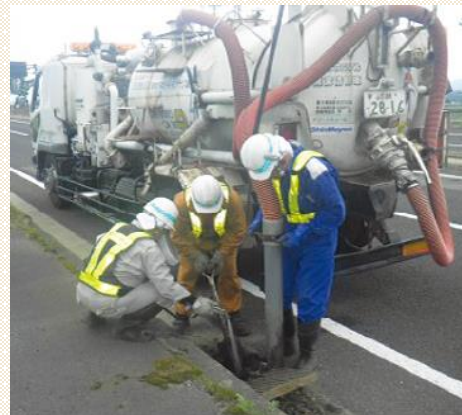
写真 排水管清掃車による道路の側溝の清掃
