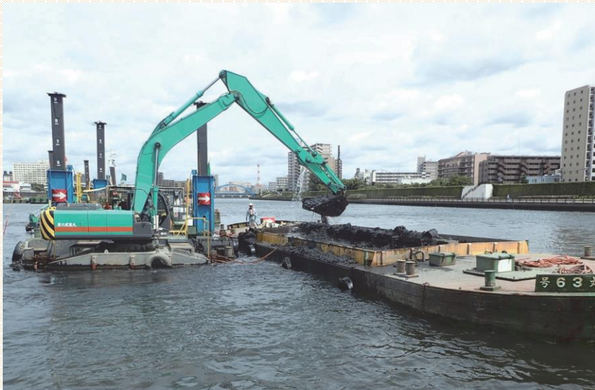
写真 河床しゅんせつ（隅田川例）
