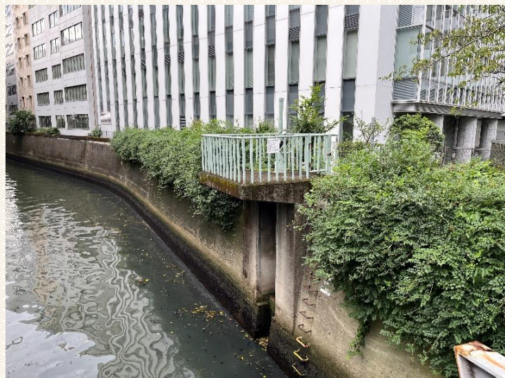
写真 河川内緑化の状況 日本橋川（鎧橋付近）
