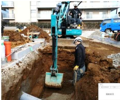
バックホウで掘削します
