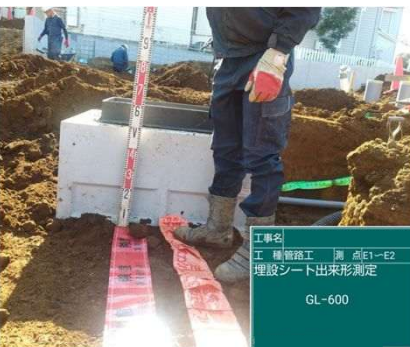
埋設シートを設置します
