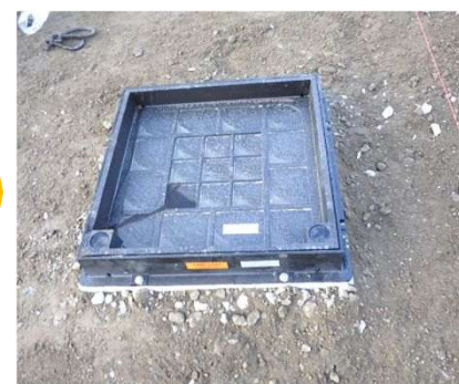
金蓋を設置して、埋戻して完了
