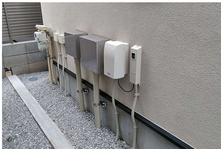
【建物側面のプルBOX設置例】
