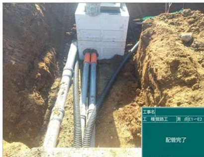
ハンドホールに管路を接続します
