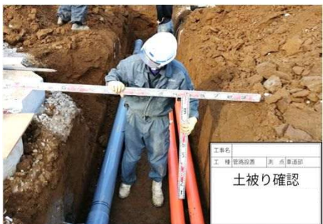
ケーブルを通す管路を敷設します
