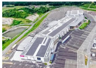
商業施設や工場の 屋上や壁面での太陽光発電
