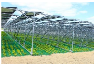
営農型発電（検討） 農地の上部空間での太陽光発電
