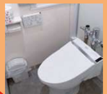
工事後 （女性専用トイレ）
