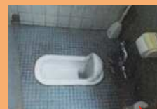
工事前 （元々は男性専用トイレ）
