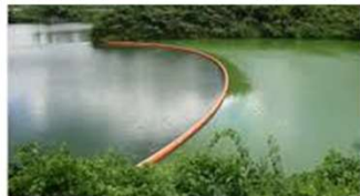
分画フェンス設置状況
