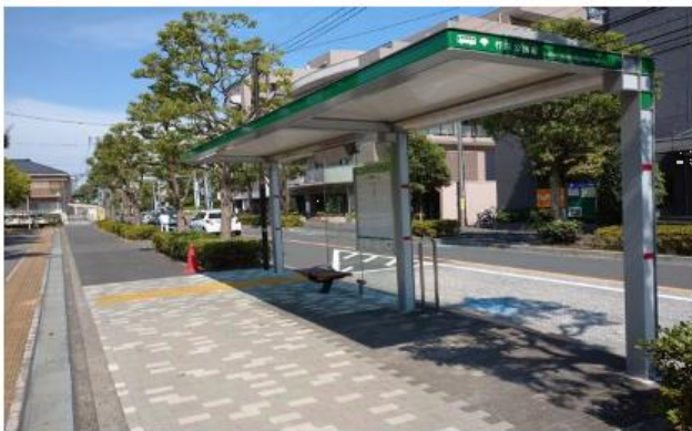
ベンチや手すり、視覚障害者誘導用ブロックなど、利用者に配慮したバス停留所の事例(バス待ち環境高質化)
