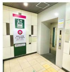
▲エレベーターによる1ルート確保
