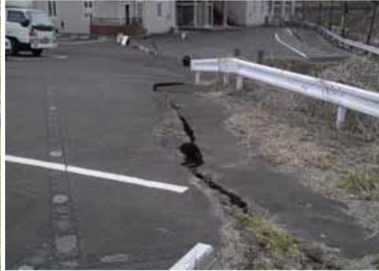
(b)のり肩の亀裂の事例
