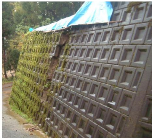
(a) 水抜穴が無い前傾した擁壁
