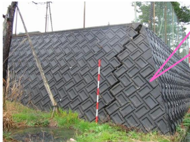
(b) 水抜穴が 20 mm と小さい事例
