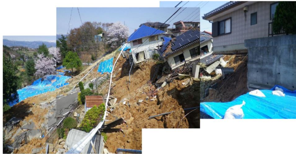
(d)液状化による側方流動の事例
