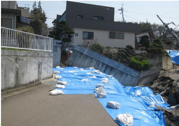
(c)腹付け盛土の崩壊の事例
