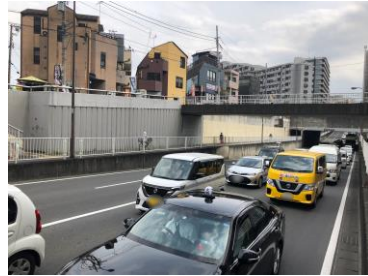
写真1)立川市・立川立体付近
