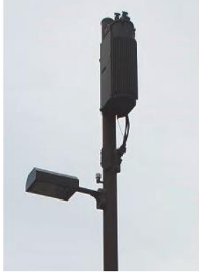
柱上トランス
