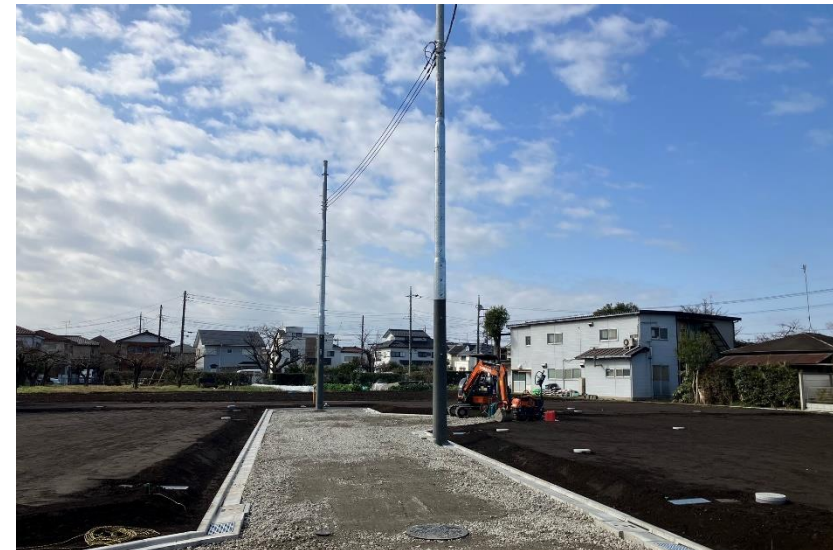
■開発道路へ電柱を新設した事例
