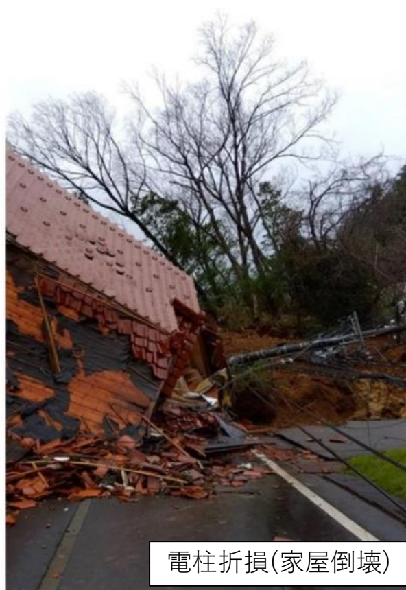
電柱傾斜(道路損壊)
