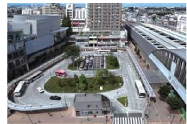
武蔵小金井駅（JR中央線）
