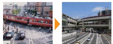
京急蒲田駅付近（京浜東北線・空港線）
