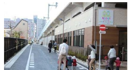
高架下空間を活用した保育所（西武池袋線）
