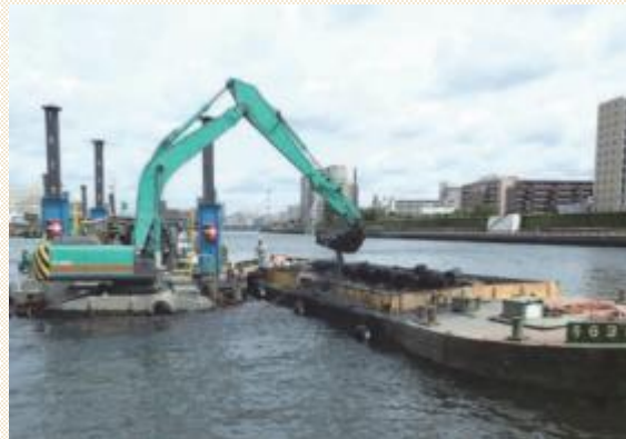
写真 浚渫（堆積している汚濁物の除去）
