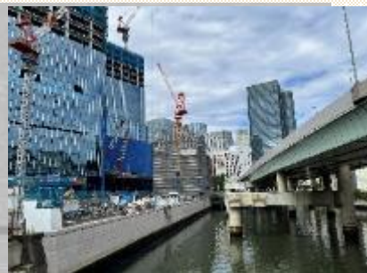
日本橋地区の開発の様子
