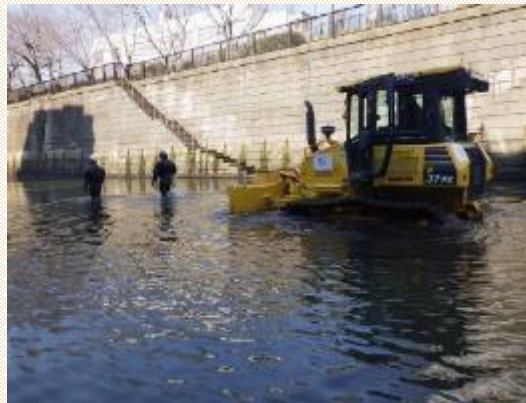
写真 河床整正 （堆積しにくい河床形状に整正）
