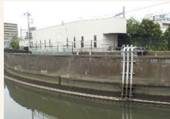
写真 無酸素状態の底層水への酸素供給
