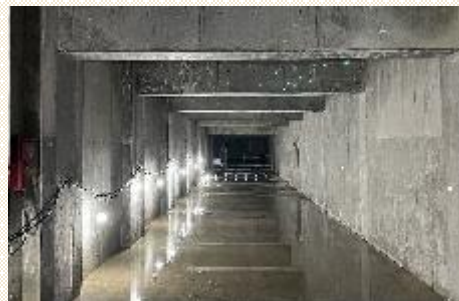
写真 貯留施設の設置
