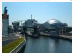
道頓堀川水門
