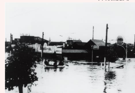
写真 昭和24年8月 キティ台風時の浸水状況 (墨田区錦糸町)
