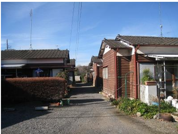
⑤木造賃貸平屋建て住宅
