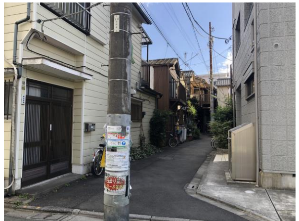
④ 老朽建築物と電柱
