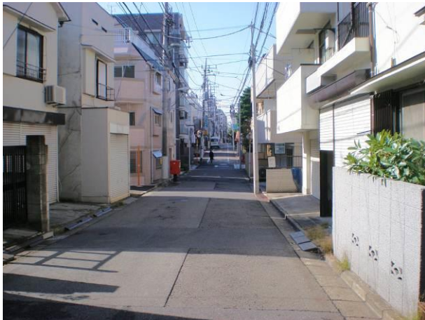
⑦ 木造住宅も数多く建ち並んでいる区画道路7号 (現況幅員 4.2～5.4m)の様子
