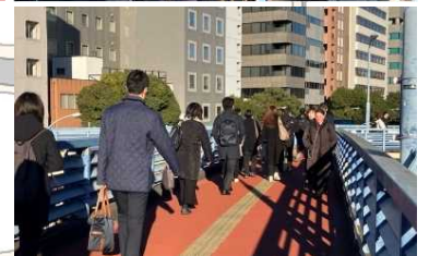
飯田橋歩道橋（階段部・歩行部）
