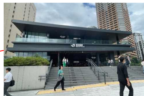
JR飯田橋駅西口駅舎の改良
