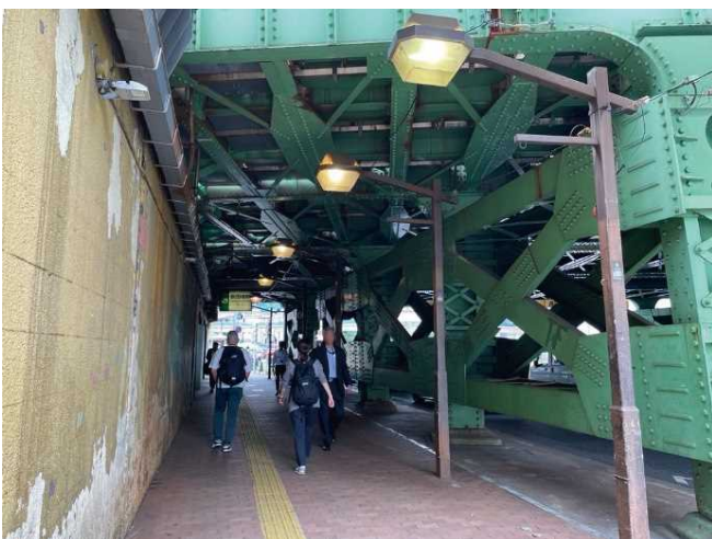
狭く暗いJR高架下の歩行空間
