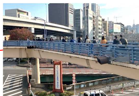
飯田橋歩道橋
