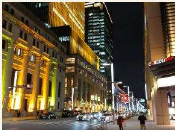
写真 歴史的建造物（三井本館）の ライトアップの様子
