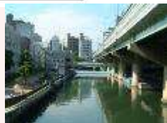
東横堀川水門
