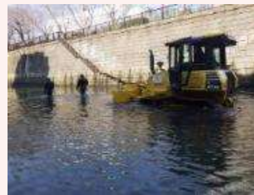
②河床の整正及び浚渫
