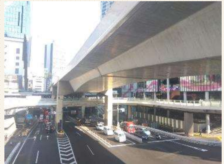
写真 首都高高架橋修景の事例 (首都高渋谷線)
