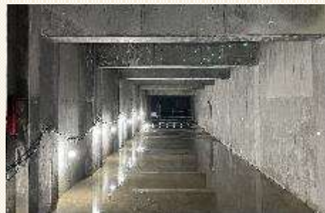
写真 貯留施設の設置
