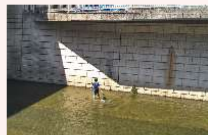
写真 神田川の江戸川橋上流 処理水放流により河川環境を改善
