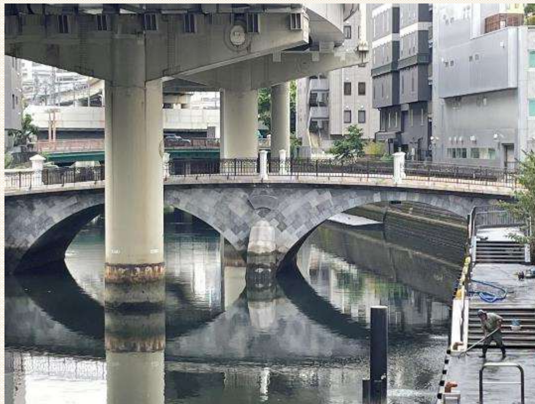
写真 復元された常盤橋の様子
