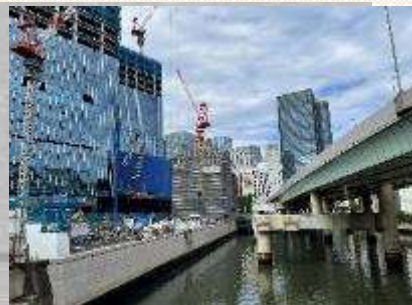
日本橋地区の開発の様子
