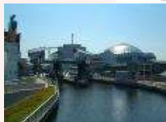
道頓堀川水門
