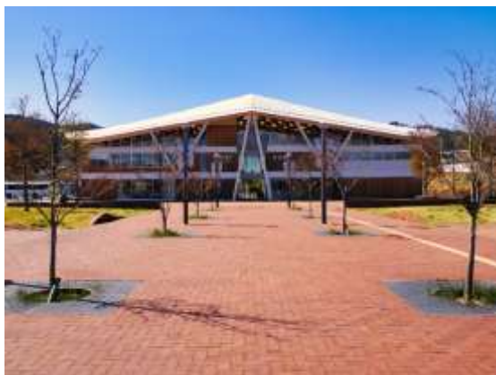
(事例) J R東日本 石巻線 (女川駅)
