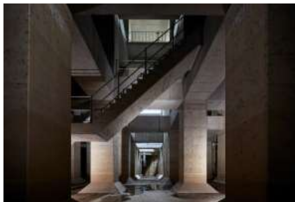
調節池（東久留米市：黒目橋調節池）
