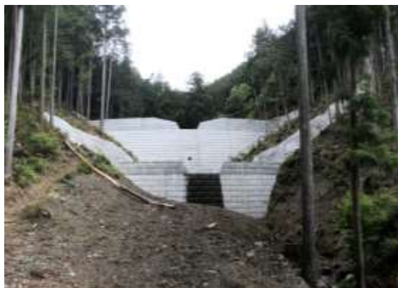
砂防事業（青梅市：中曽川砂防堰堤）
