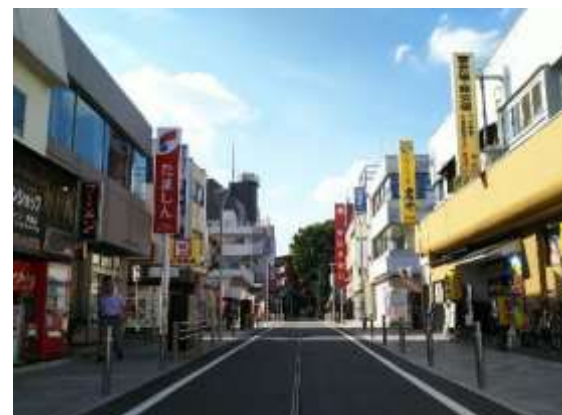
無電柱化（拝島駅周辺）
