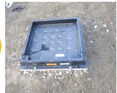
金蓋を設置して、埋め戻して完了
