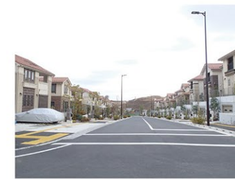
区画道路の無電柱化の事例 稲城市 南山東部地区
