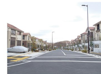
区画道路の無電柱化の事例 稲城市 南山東部地区
