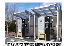
EVバス充電施設の設置
