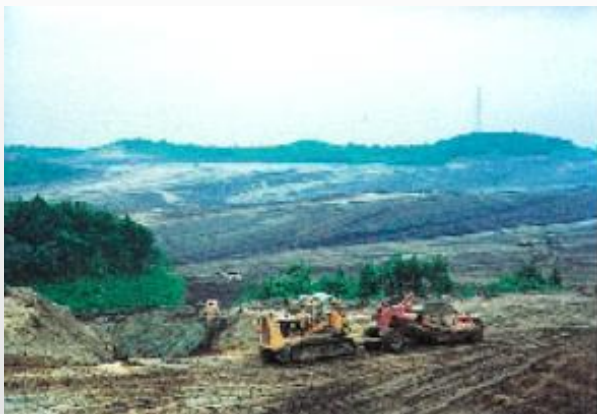
諏訪地区での造成工事 (昭和43(1968)年9月) ※1
