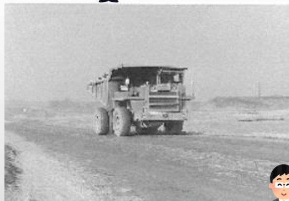
大型重機を用いた造成工事 (昭和43(1968)年頃) ※1
