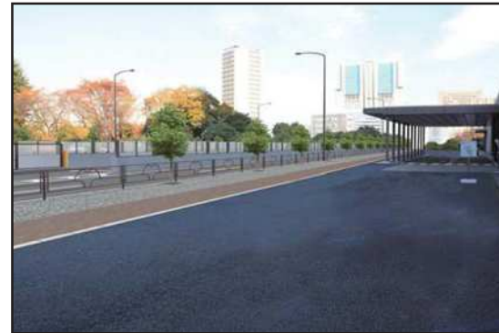
工事の完了後
