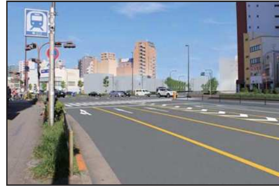
工事の完了後
