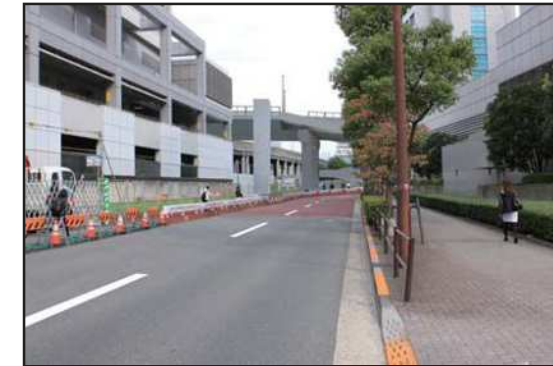
工事の完了後
