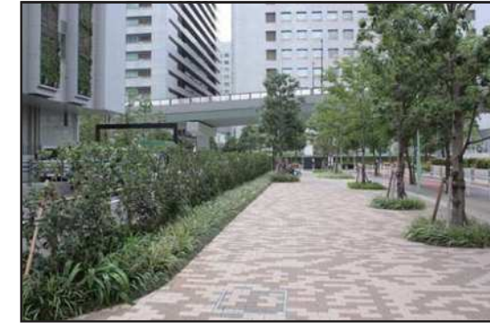
工事の完了後
