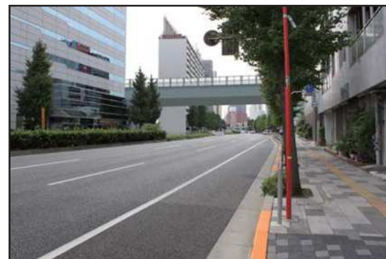
工事の完了後
