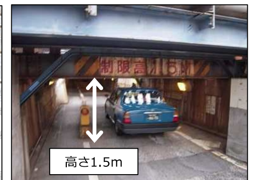
高輪橋架道橋の状況
