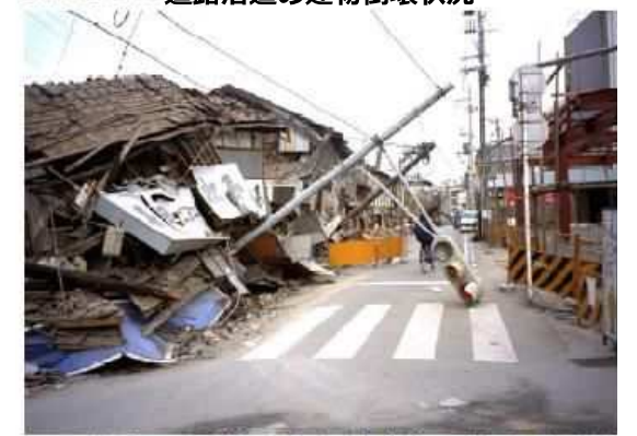
阪神・淡路大震災における道路沿道の建物倒壊状況
