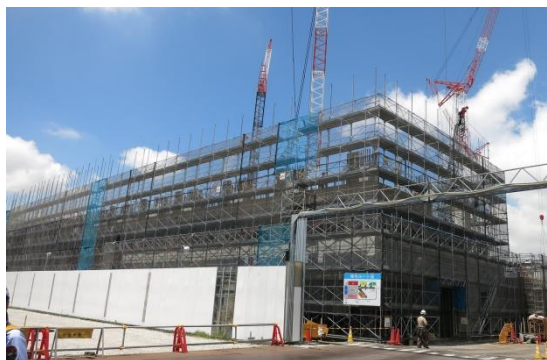
5-5 街区 地上躯体の整備状況(地上から)
