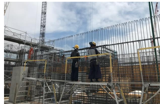
5-5 街区 地上躯体の整備状況(鉄筋組立)
