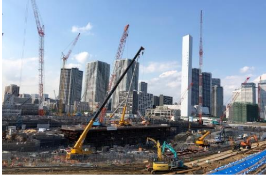
5-6 街区 地下の掘削状況（遠方から）
