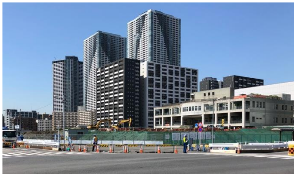
5-7 街区 工事着手前の状況
