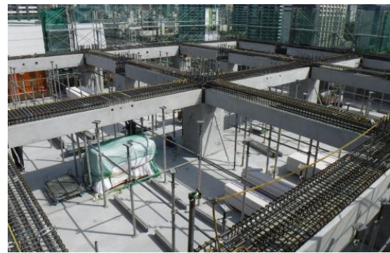
5-3 街区 地上躯体の整備状況(上空から)
