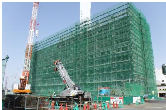
5-3 街区 地上躯体の整備状況(地上から)
