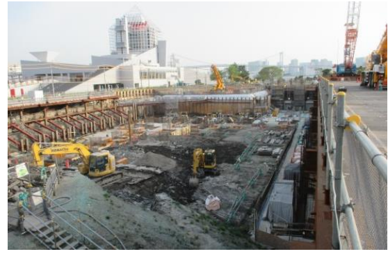
5-6 街区 地下の掘削状況（近方から）
