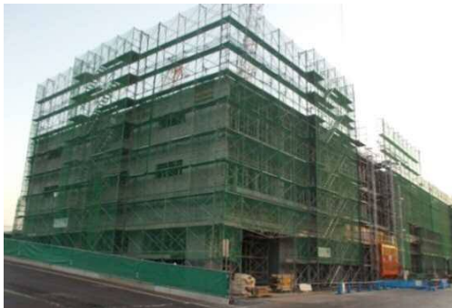
地上躯体の整備状況（5-3街区）
