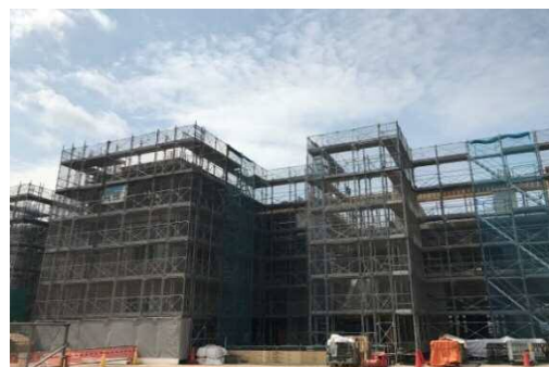
地上躯体の整備状況（5-5街区）
