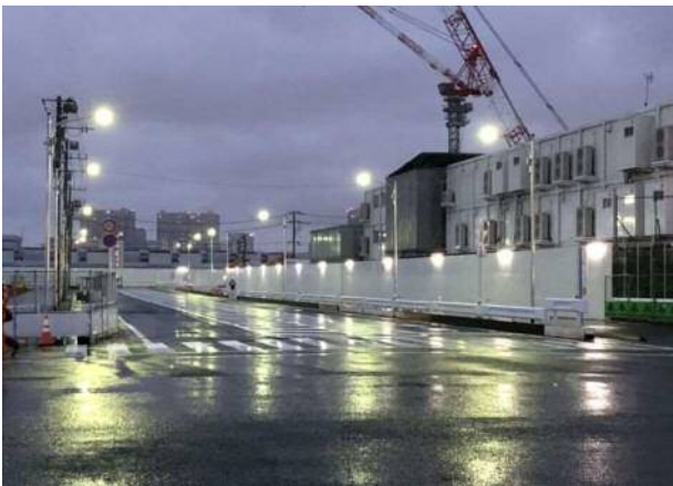
切替え直後の5-2号線の様子
