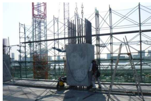
工場で製作した柱の組み立て状況
