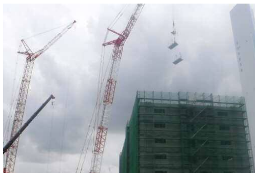
クレーンによる運搬状況
