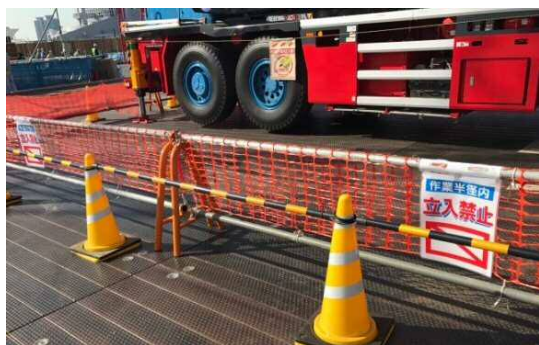
2重囲いの設置状況
