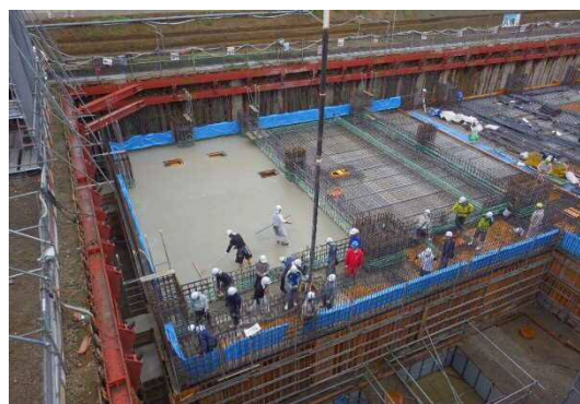
コンクリート打ち込み状況
