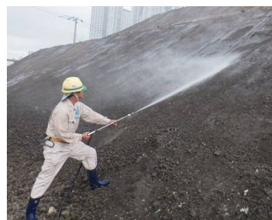
固化材の散布状況
