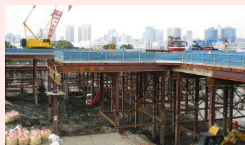
かせつこうだい 設置された仮設構台
