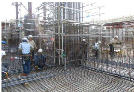
鉄筋の組み立て状況
