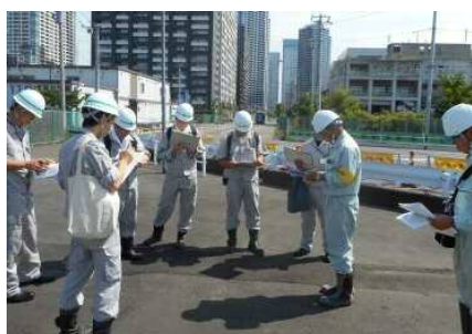
安全パトロール開始前の作業確認
