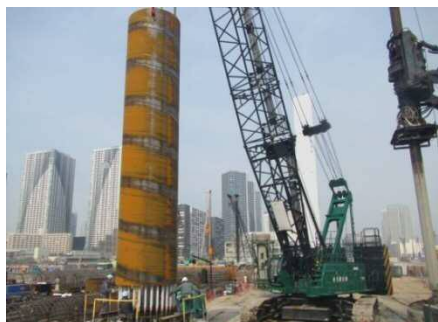
工場で製作された鋼管杭 の施工状況
