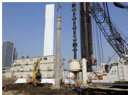
工場で製作されたコンクリート杭 の施工状況
