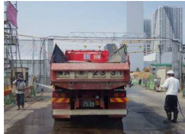
タイヤの洗浄状況
