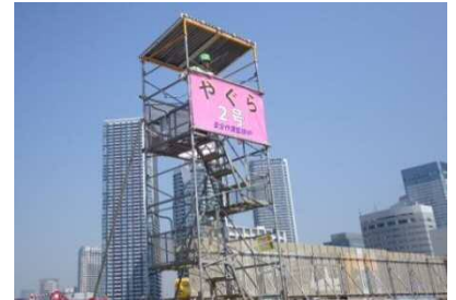
現場内の監視状況
