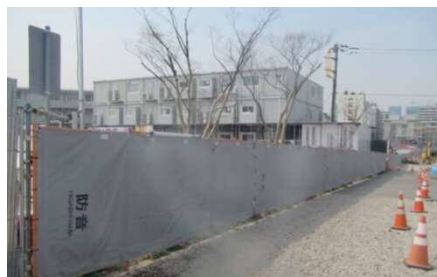
防音シートの設置状況
